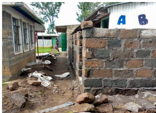
Nya klassrum byggs på Bethesda.
